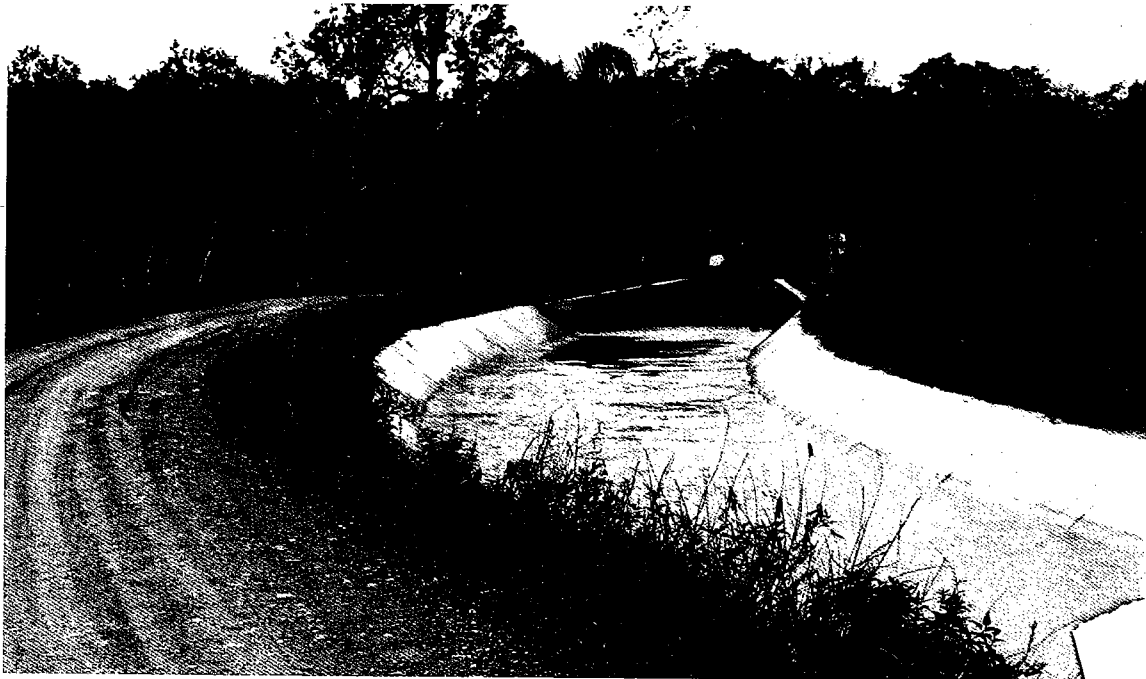
▲灌漑地区の水路。コンクリートでライニングされており、状態は良く、水路のみならず補修用道路（写真左部分）についても持・管理されています。
