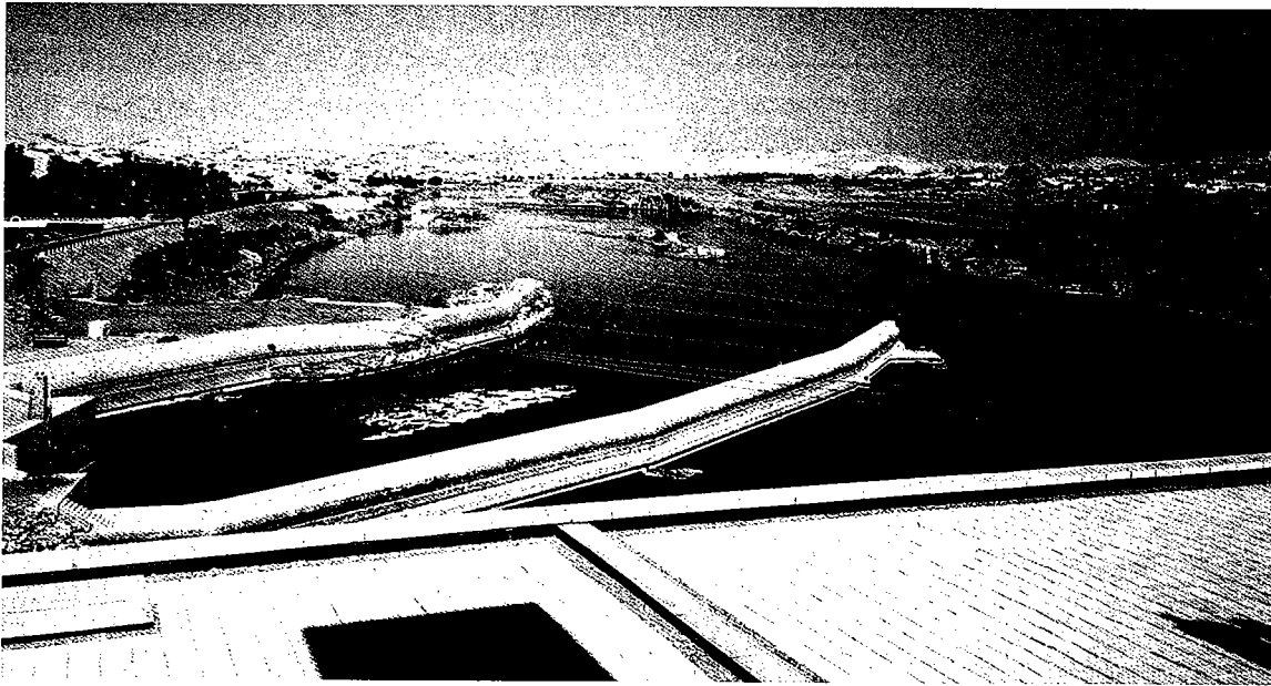
▲発電所下流の状況。下流域の水需要に応じて本発電所より放流しています。
