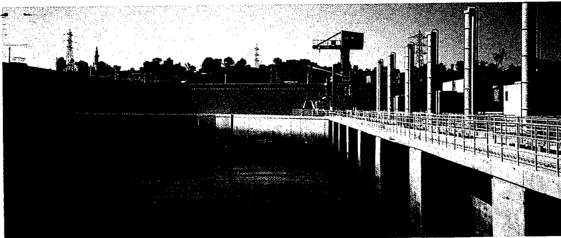
▲本発電所のための調整池。心配されたアスワンダム接合部分からの漏水もなく、調整池としての機能（水位、流量の調整）を十分に果たしています。
