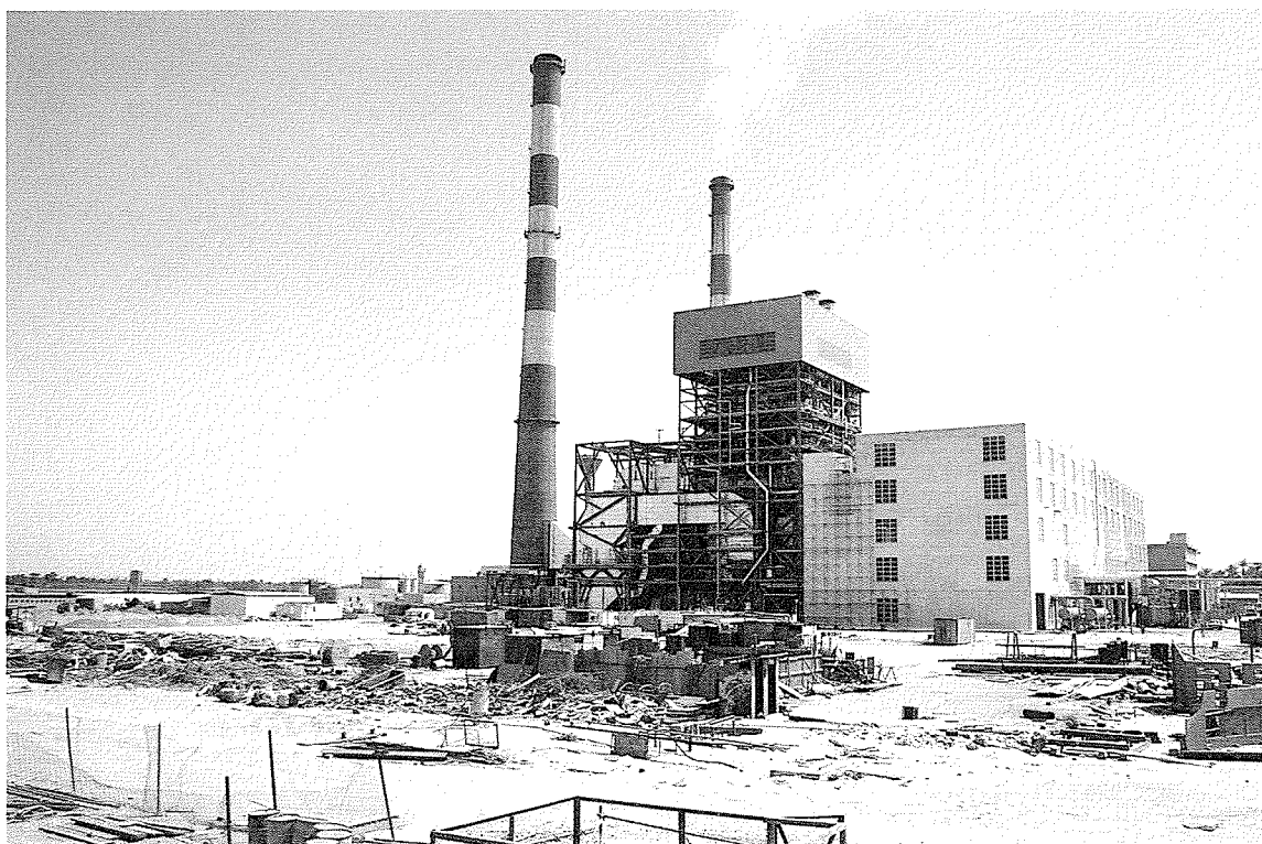
アシュート火力発電所全景
