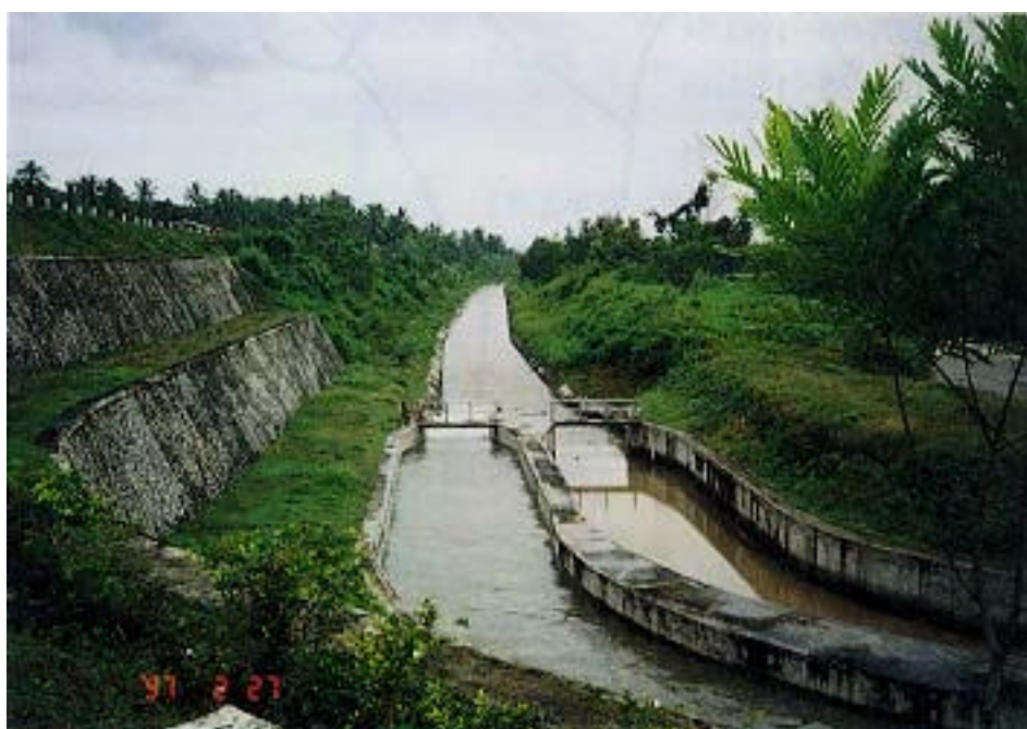
ランケメ幹線水路 ランケメ取水堰から直ちにつながる幹線水路 (画面手前から奥へ流水している)
