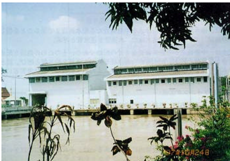
サムラエ原水取水場
