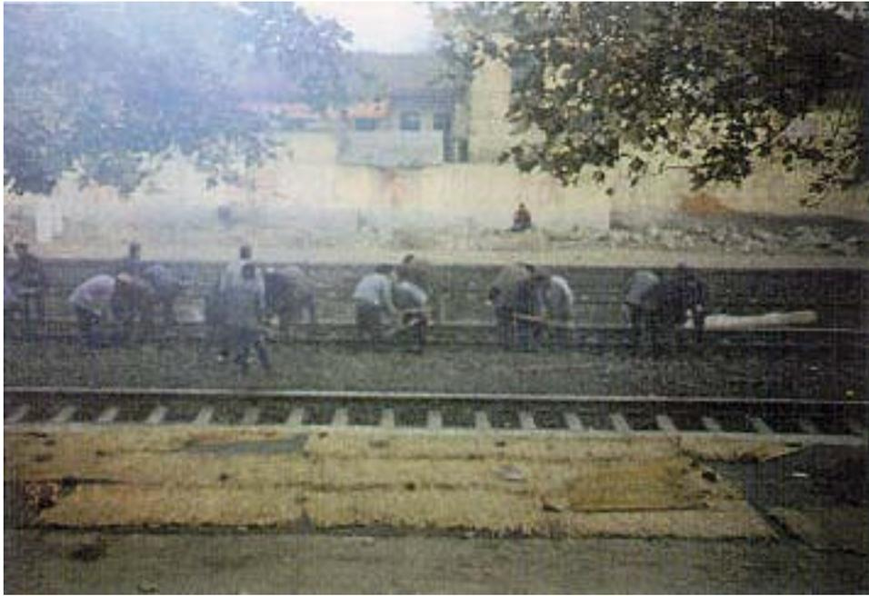
人力による保線作業（道床突固め）
