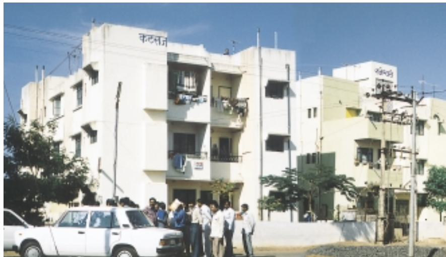
同じく住宅金融会社の融資を受けて建設された中所得者層向け住宅（ムンバイ(ボンベイ)市から北東に約200kmの距離にあるナシク市）
