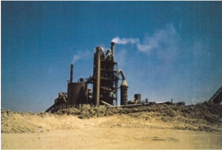
ベニスエフ・セメント工場
