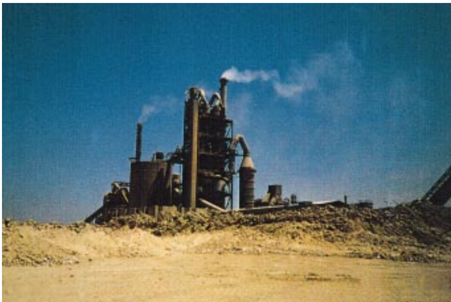
ベニスエフ・セメント工場
