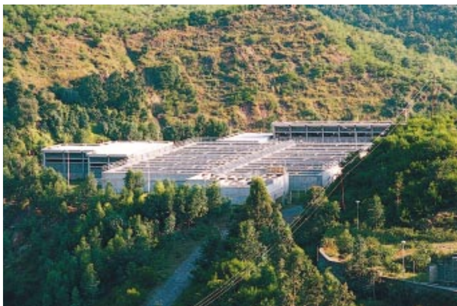
シムリ浄水場増設分遠景
