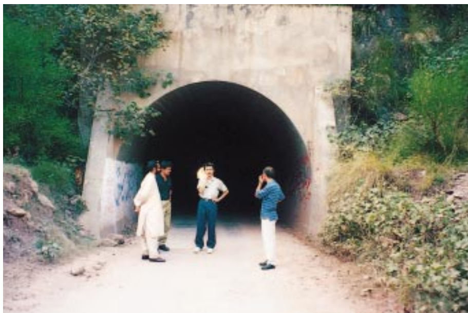
新旧送水管が埋設されているトンネル
