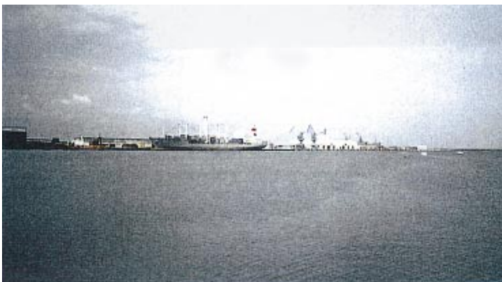
タコラディ港（クレーンと船舶がOECF事業により調達された）
