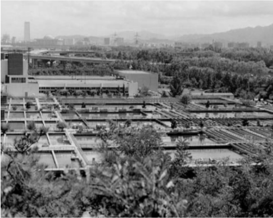
八堂水源地の沈殿地
