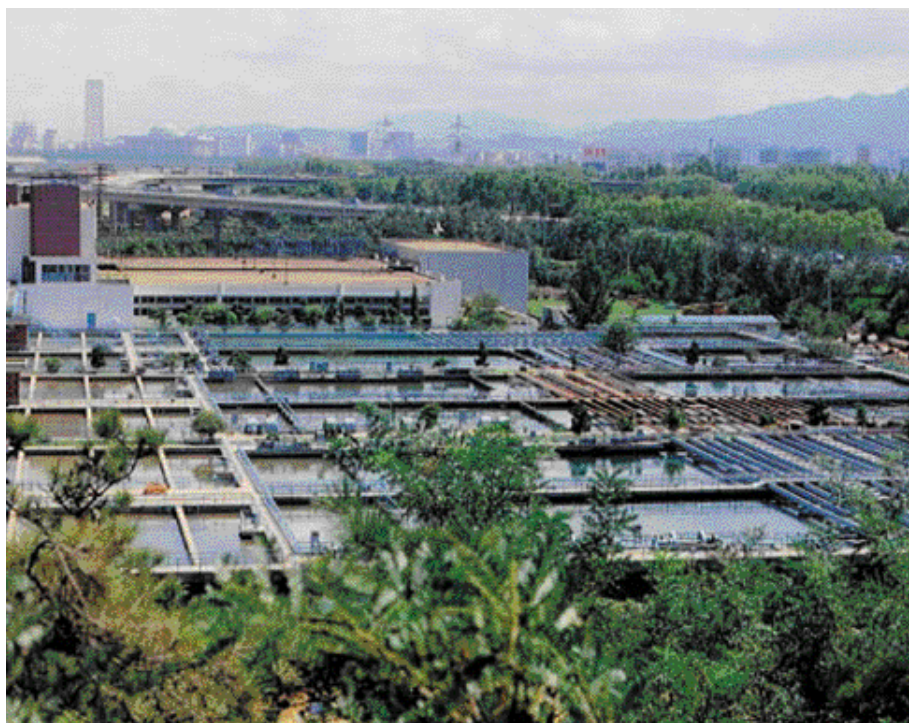
八堂水源地の沈殿地
