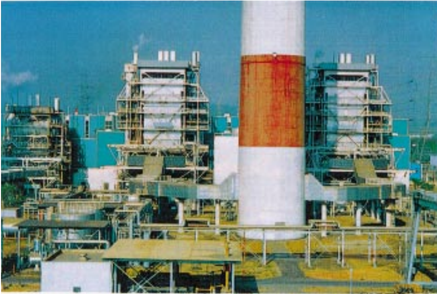
発電機（左：3号機、右：4号機）
