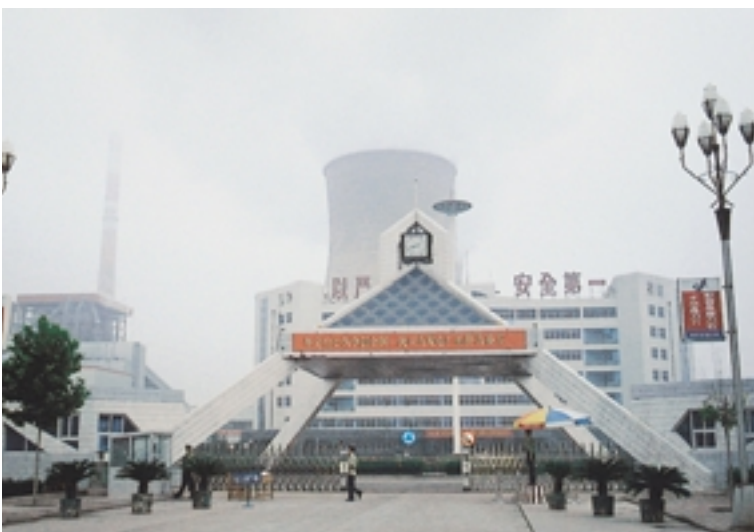
衡水市内の火力発電所。 京九線で運ばれてくる石炭を 使用している。
