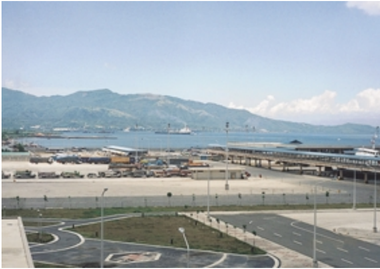
バタンガス港 (拡張され、構内での駐車が可能に)
