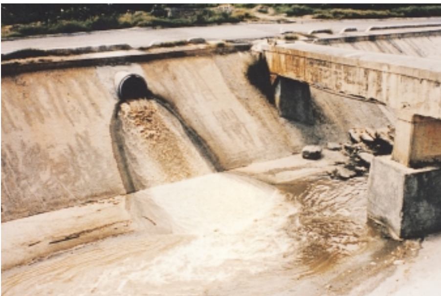
モンテレイ都市圏における本事業実施 前の下水放流状況
