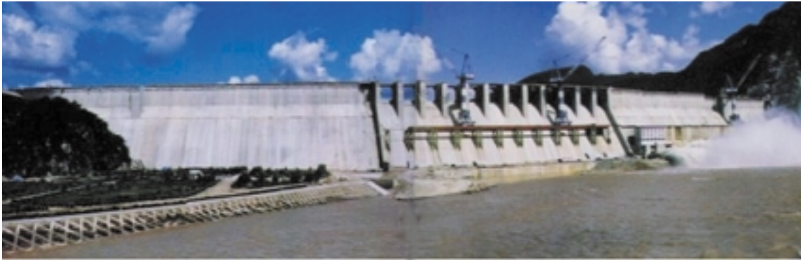
観音閣多目的ダムの全景
