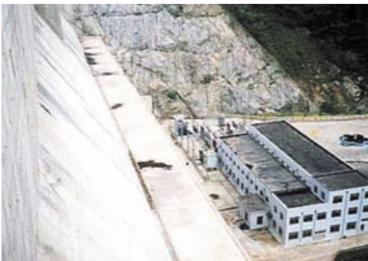
ダム堤上から発電所を見る
