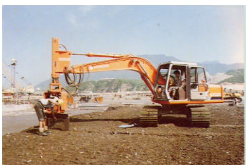
工程 3 目地きり機によって横継ぎ目を造成
