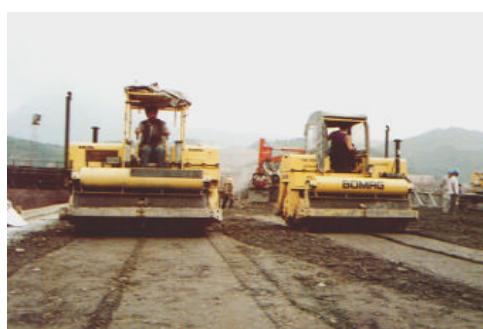
工程 4 ローラーによる締め固め
