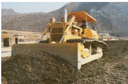
工程 2 ブルドーザーで均一にならす
