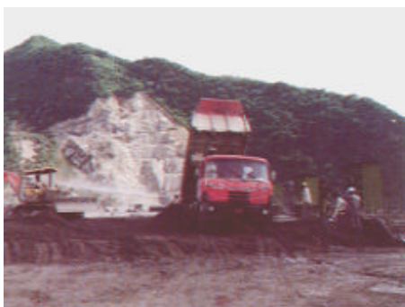
工程 1 ダンプでコンクリートを下ろす
