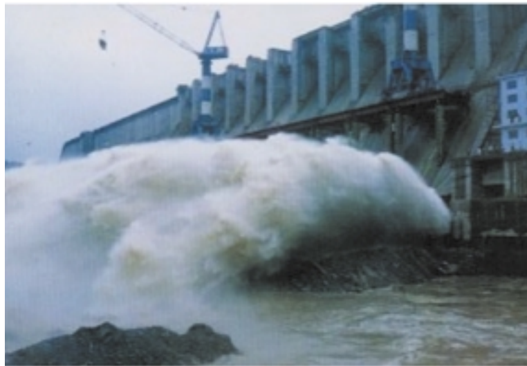
底孔からの放水
