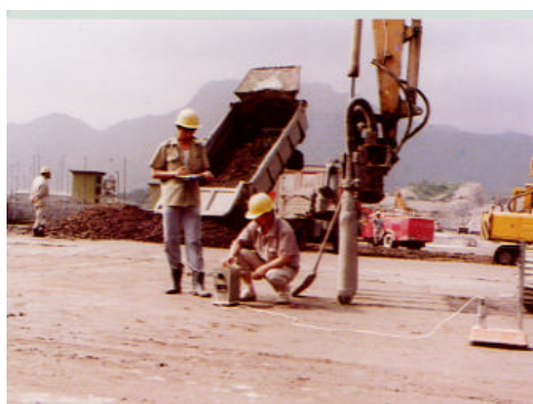
工程 5 締め固めの検査
