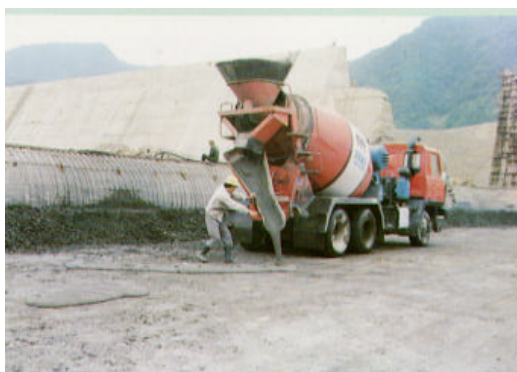
工程 6 モルタル打ち
