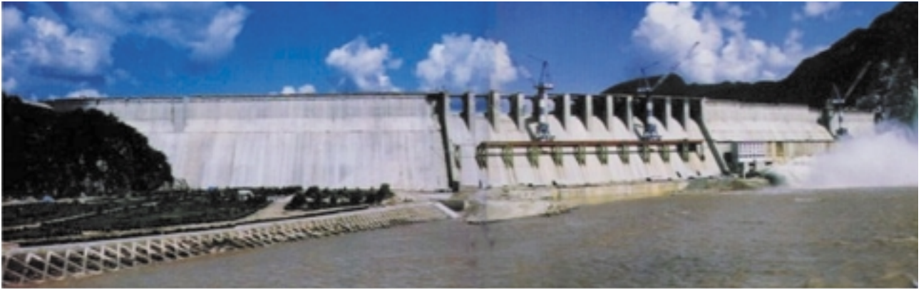
観音閣多目的ダムの全景
