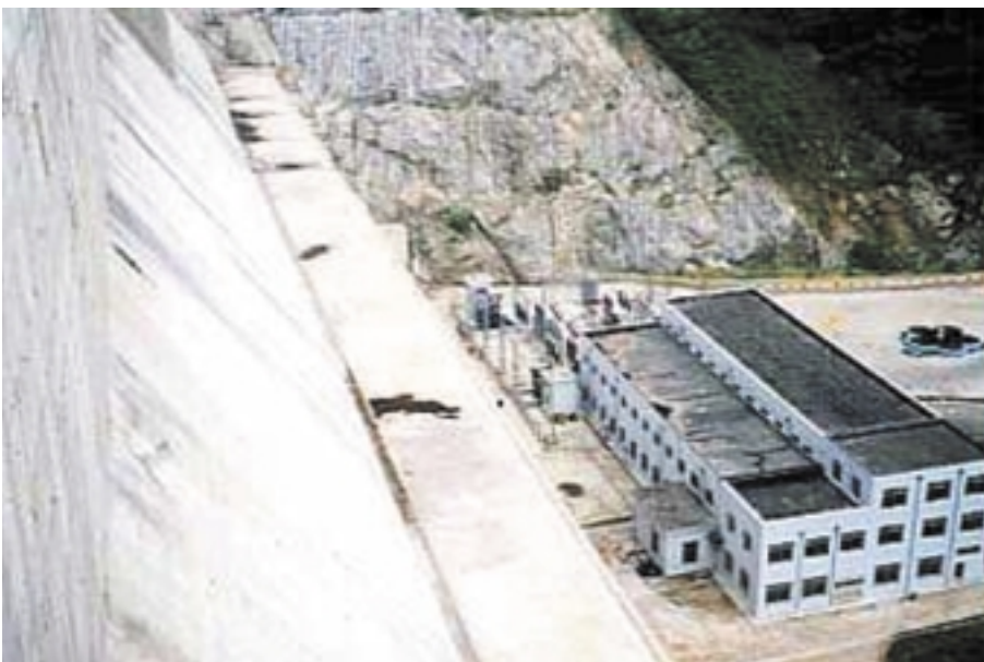
ダム堤上から発電所を見る
