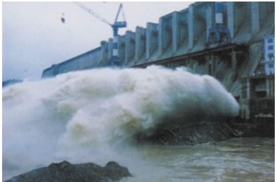
底孔からの放水
