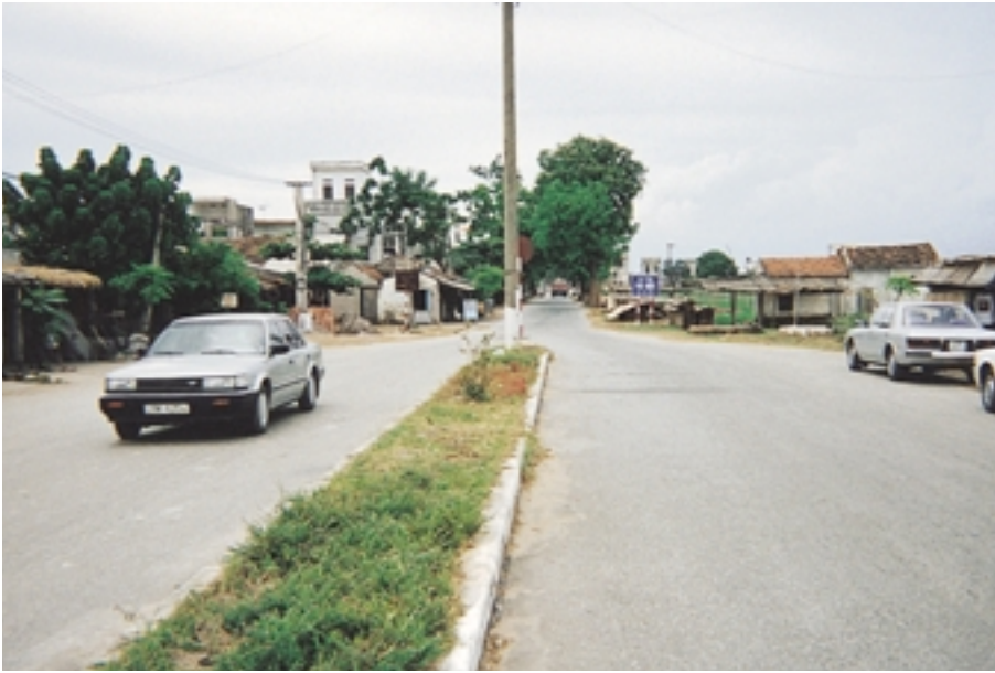
本借款により拡幅された道路（ハ・タイ省、道路が狭くなっている地点が省境、その先はハノイ市）
