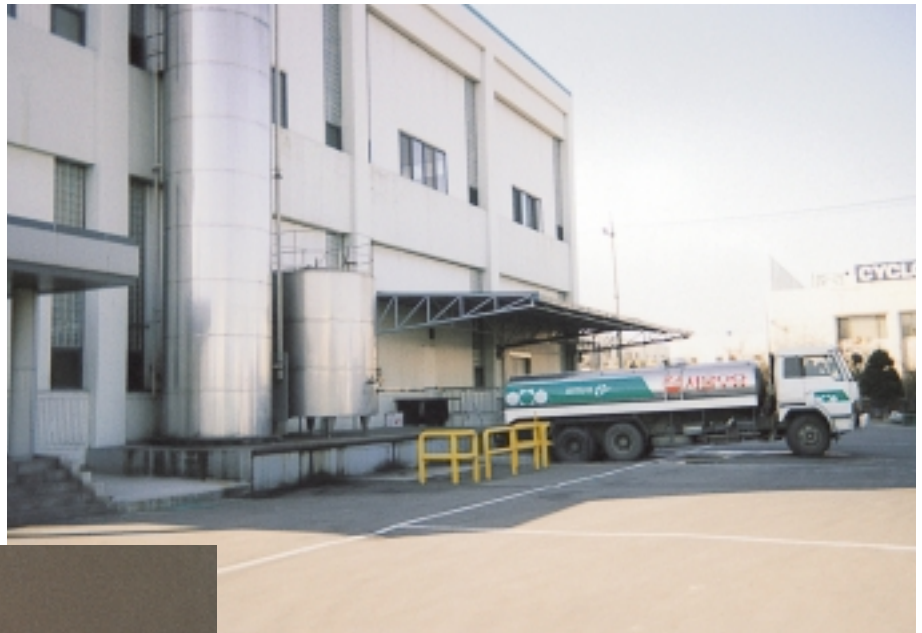
本事業により増設された市乳処理工場 （原乳をトラックのタンクに注入しているところ）
