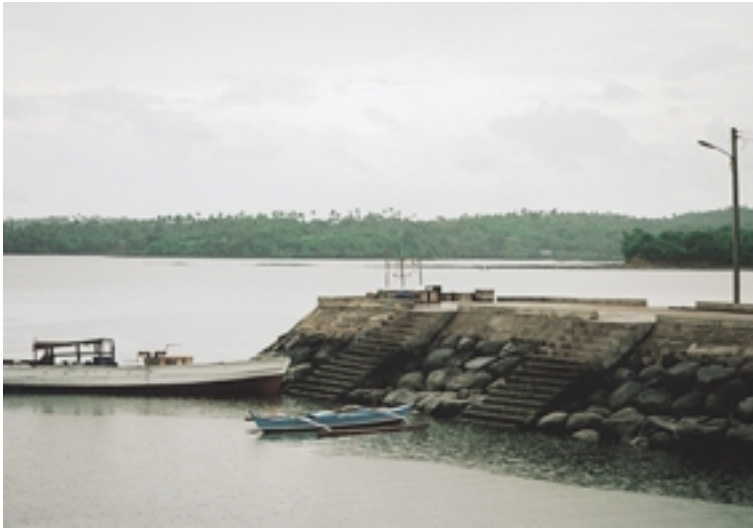
Pitogo港 商業漁船が利用する小型突堤
