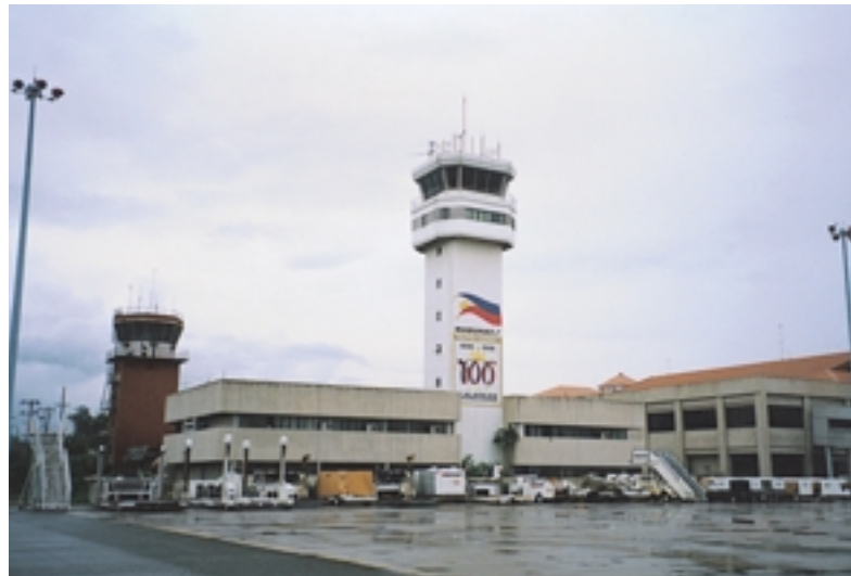
マクタン空港Control Tower
