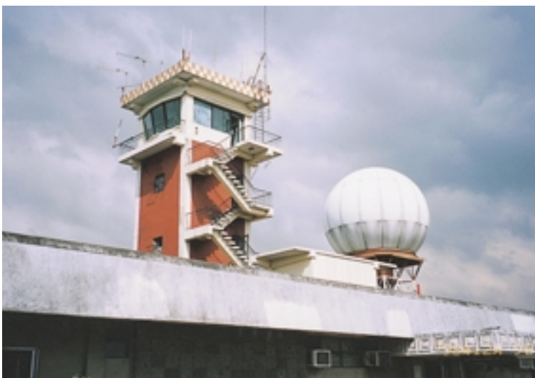
レーダー局舎 ( ARSR/SSR )
