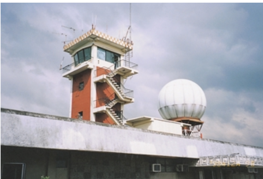
レーダー局舎（ARSR/SSR）
