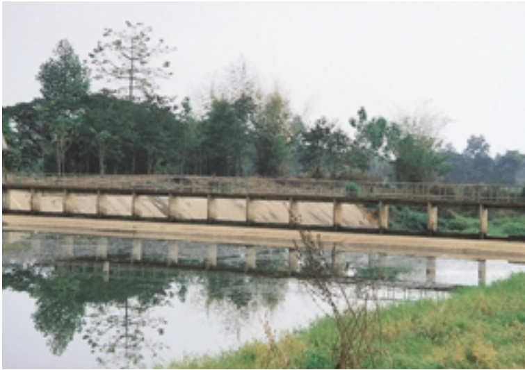
貯水池ならびに余水路
