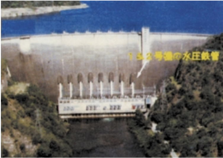
タイ「プミボン水力発電所リハビリ事業」 1 & 2号機の水圧鉄管（右の2本）
