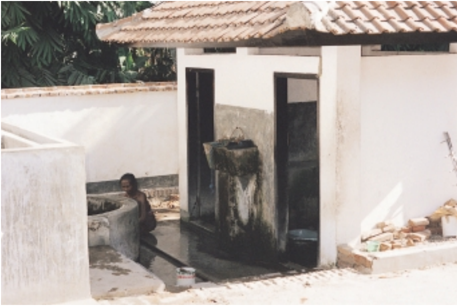
インドネシア 居住環境改善 北スマトラ州山間部農村内の井戸、ト イレ、水浴場、洗濯場が併設された共 同水関連施設
