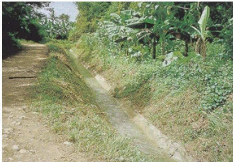
マリナオダム吐水口
