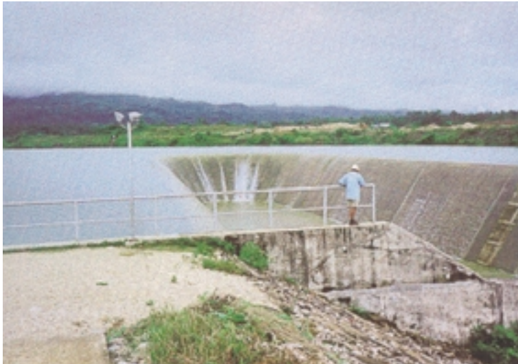
灌漑支線水路ライニングが施された
