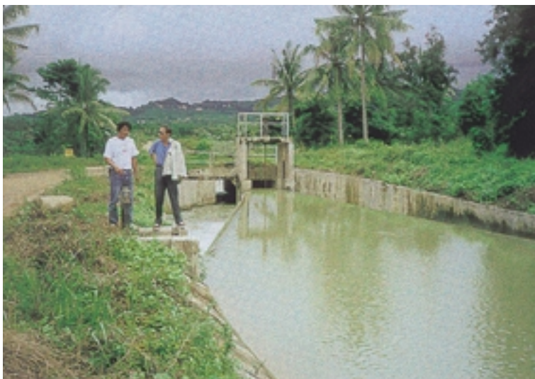
灌漑水路および監視施設
