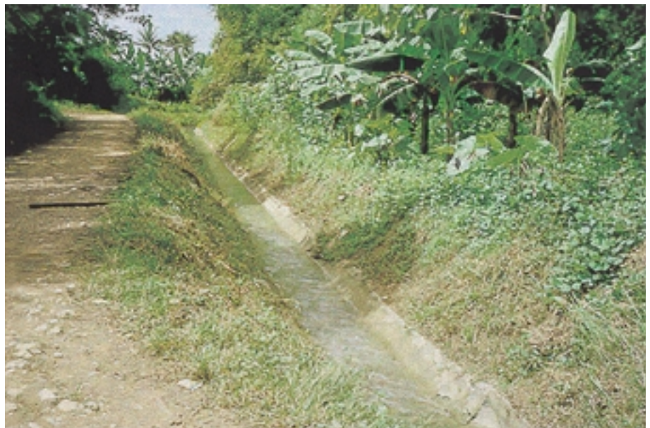
マリナオダム吐水口
