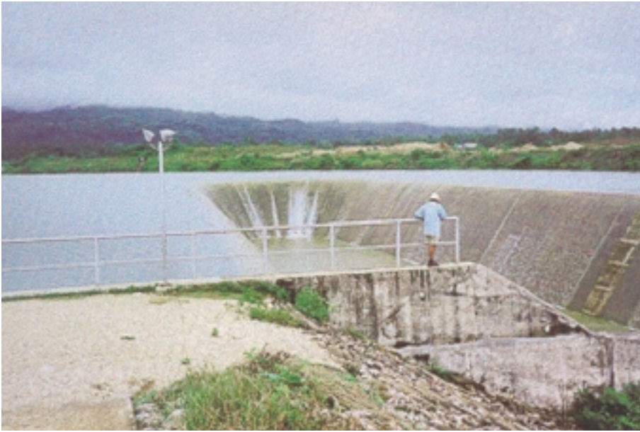
灌漑支線水路ライニングが施された
