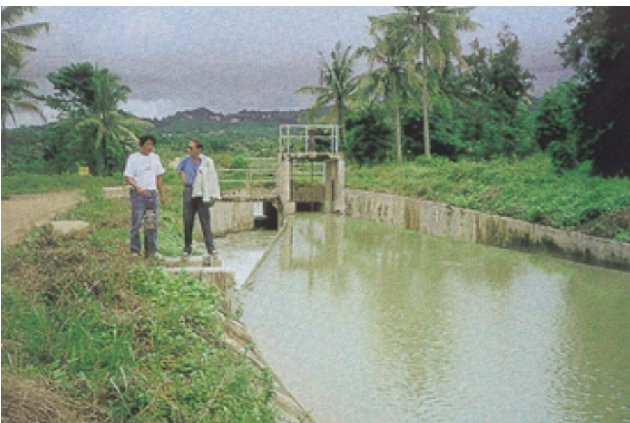
灌漑水路および監視施設
