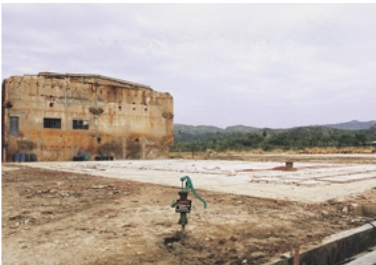
旧工場跡地（水銀除去作業終了後、工場の下部基礎はコンクリートで被覆された。手前の管井栓は、水銀モニタリング用）
