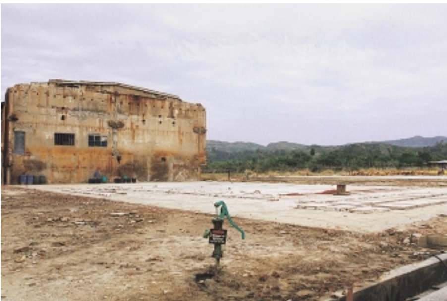
旧工場跡地（水銀除去作業終了後、工場の下部基礎はコンクリートで被覆された。手前の管井栓は、水銀モニタリング用）
