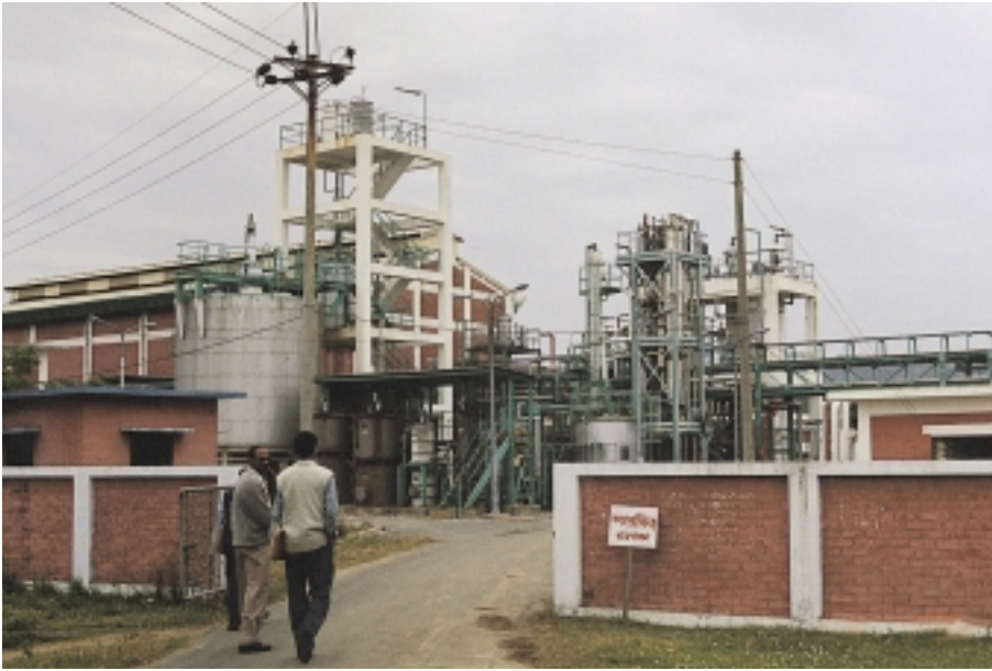
改修・更新後の工場設備
