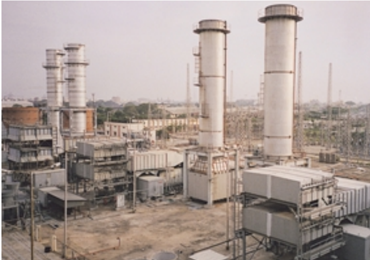
ベイスンブリッジ火力発電所全景
