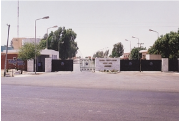
ジャムシヨロ火力発電所入口
