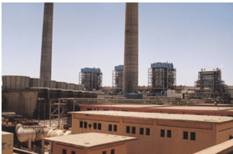
ジャムシヨロ火力発電所近景 (後方左には冷却塔が見える)
