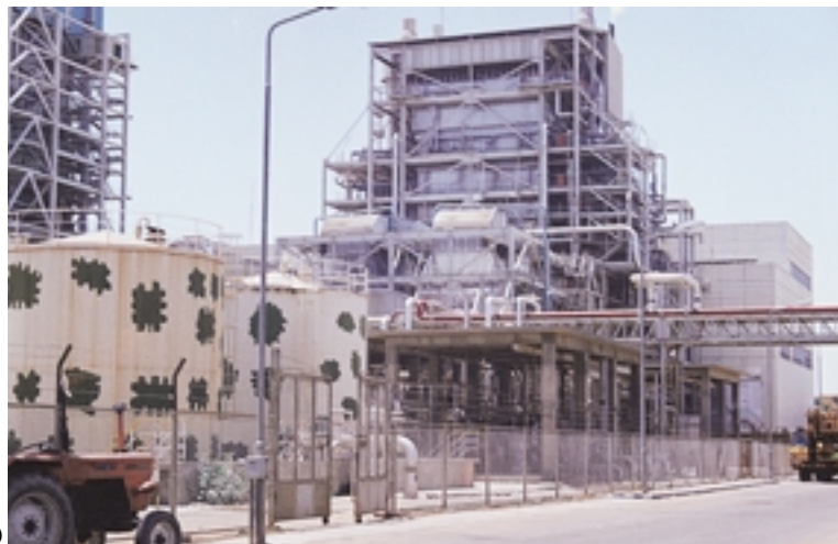
ジャムシヨロ火力発電所近景 (後方にボイラー並びにタービン棟が見える)
