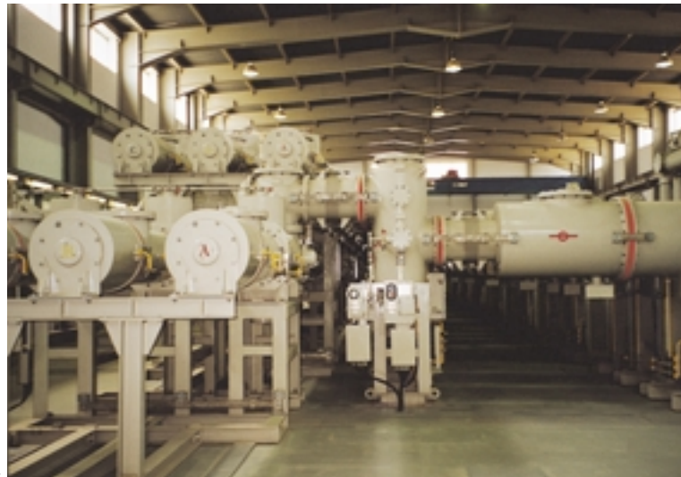
ガス絶縁開閉装置
