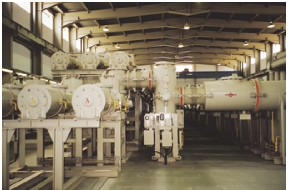
ガス絶縁開閉装置
