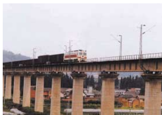
南昆線昆明～昆明南間の陸橋
