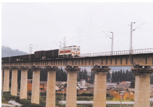
南昆線昆明～昆明南間の陸橋
