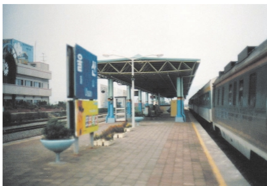
本事業により建設された蔚山駅
