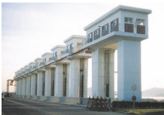
本事業にて導入された防潮堤
