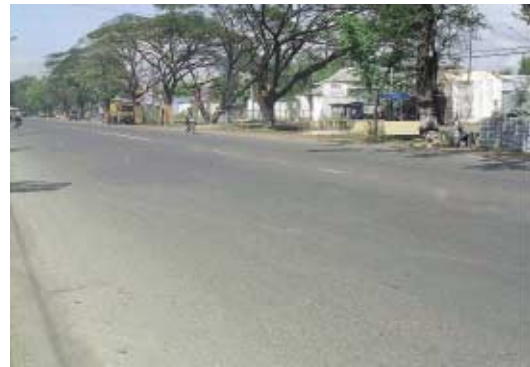
補修された交通量の多い幹線道路 (中部ジャワ州セマラン市)
