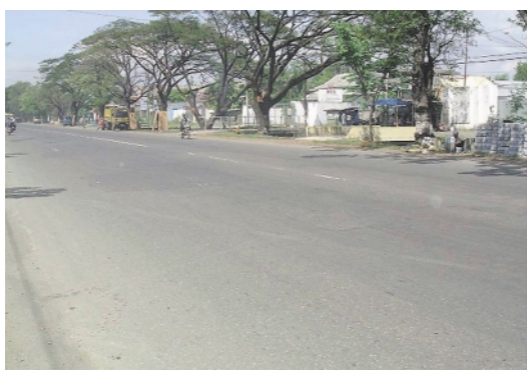
補修された幹線道路（ジャワ州セマラン市）
