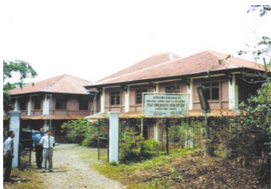
ジャカルタ市郊外のメンテナンス・センター
