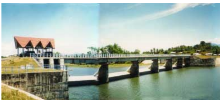
本事業にて建設された頭首工
