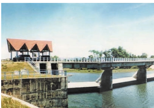
本事業にて建設された頭首工
