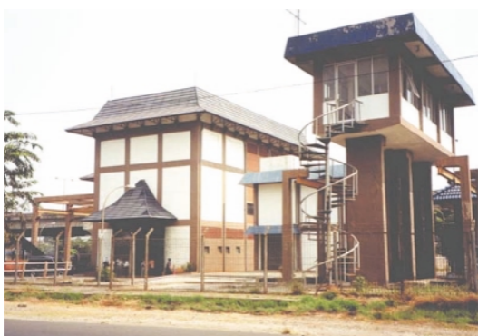
アンチョール排水機場
