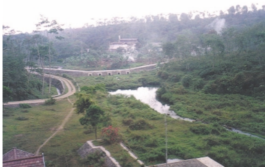
事業地域内の砂防施設
