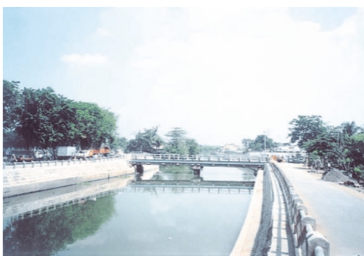
本事業により改修された護岸工（ジョゴロヨ橋付近）
