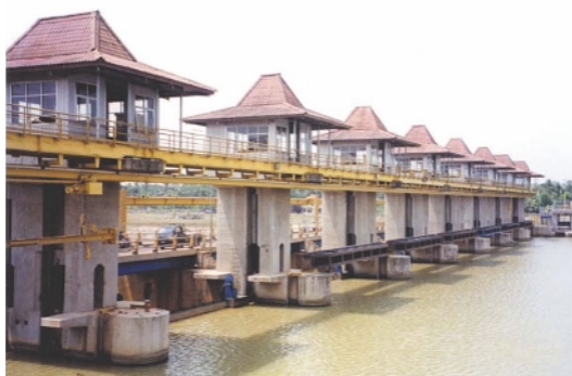
パマラヤン堰（頭首工）の全景
