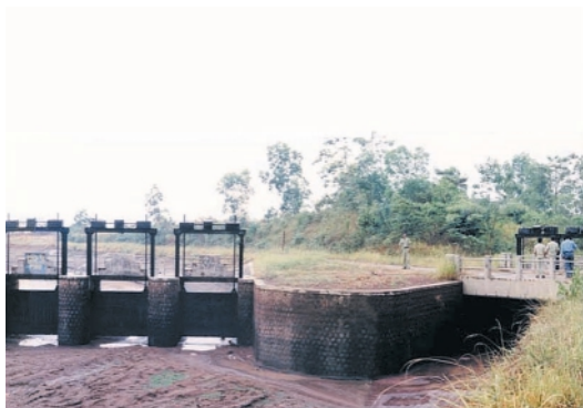
幹線用水路（左手）からの配水分岐点（右手）
