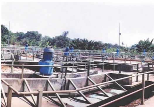
浄水施設全景
